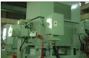
低圧電動機点検整備据付工事
