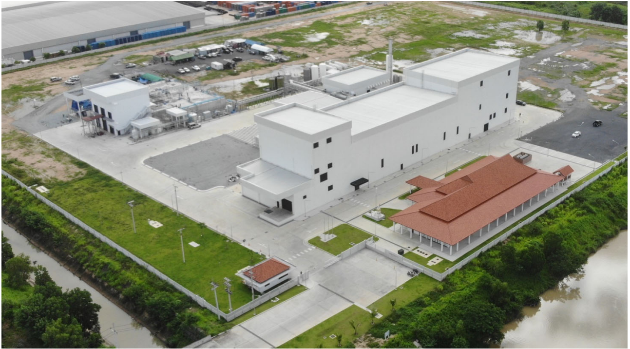
【Spiber (Thailand) Ltd. ラン工場】
