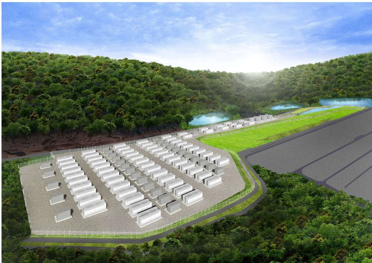
「米原湖東蓄電所」イメージ画像（オリックス提供）
